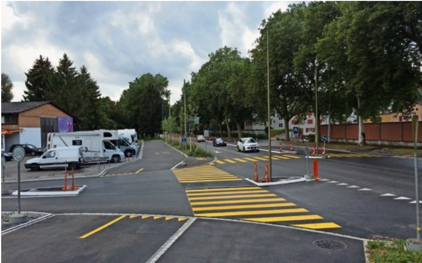
Provisorische Lösung an der Abzweigung Frauenfelder-/Albert-Einstein-Strasse. Das hier geplante Lichtsignal soll Velofahrer weitgehend bevorzugen.
