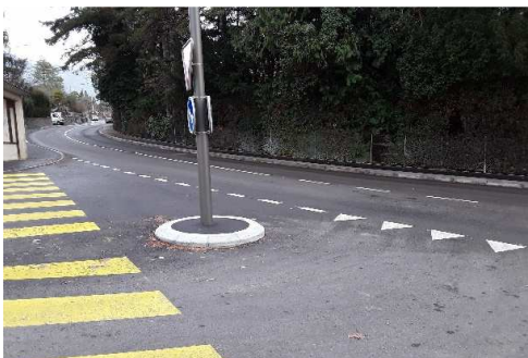
Exemple de point faible « sécurité »
