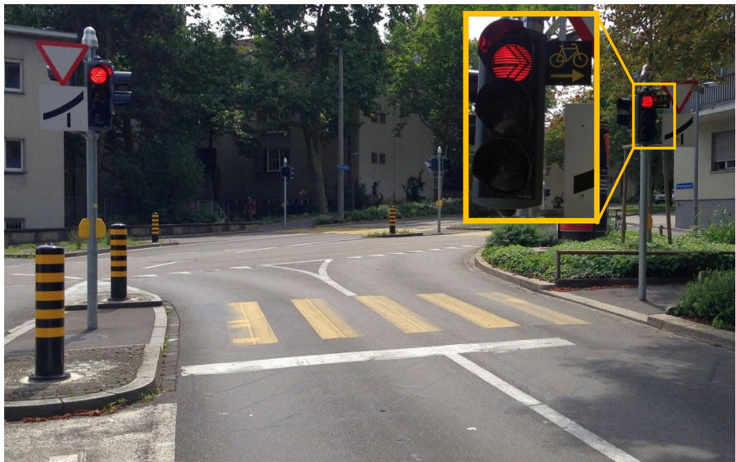
Abb. 46 Ansicht an der Klingelbergstrasse / Schanzenstrasse
