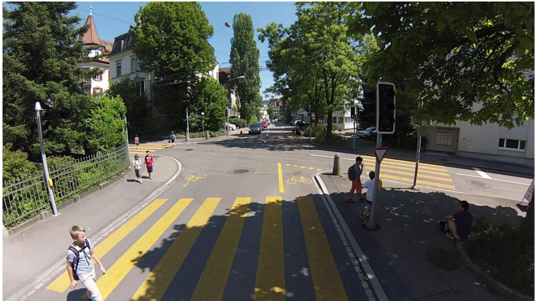
Abb. 35 Ansicht an der Hofackerstrasse / Freie Strasse
