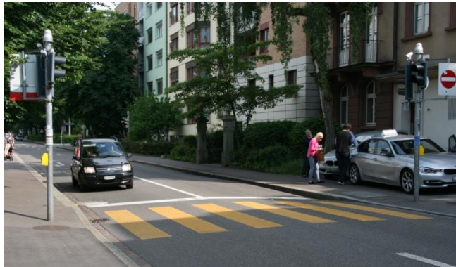
Abb. 12 An der Ecke Gempen- / Dornacherstrasse in Basel wird die Grünphase in Abhängigkeit des Fussgängeraufkommens verlängert (Quelle: Rapp Trans AG)
